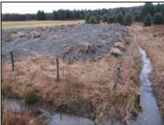
**Point I48** :Tas de gravier et sable en bordure du fossé, sans mesure de contrôle.
