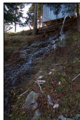
**Point 110** : Écoulement à fort débit et érosion en aval. Sorties de drains.
