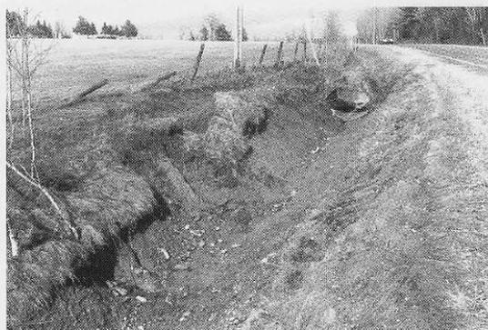
**Photographie no 1 :** Section nettoyée à l'été 1995 selon la méthode traditionnelle. Cette photographie prise au printemps 1996 permet de constater les effets dévastateurs de l'érosion (solifluxion et décrochage) sur les talus du fossé.
