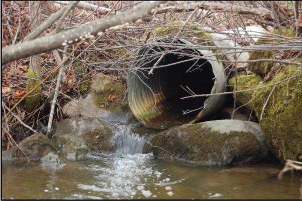
**Point I38** :Ponceau de métal avec écoulement sur le pourtour de ce dernier.
