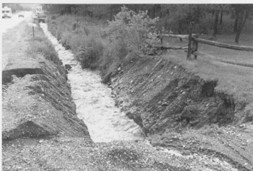
Photographie no 2 : Début de section nettoyée selon la méthode traditionnelle pour les premiers mètres, puis selon la méthode du tiers inférieur pour le reste. La photographie a été prise lors de la période de fortes précipitations de la mi-juillet 1996 et moins d'une semaine après l'intervention de nettoyage du fossé. Remarquer la forte érosion déjà en place dans les premiers mètres alors que la partie creusée selon la méthode du tiers inférieur est demeurée presque intacte.
