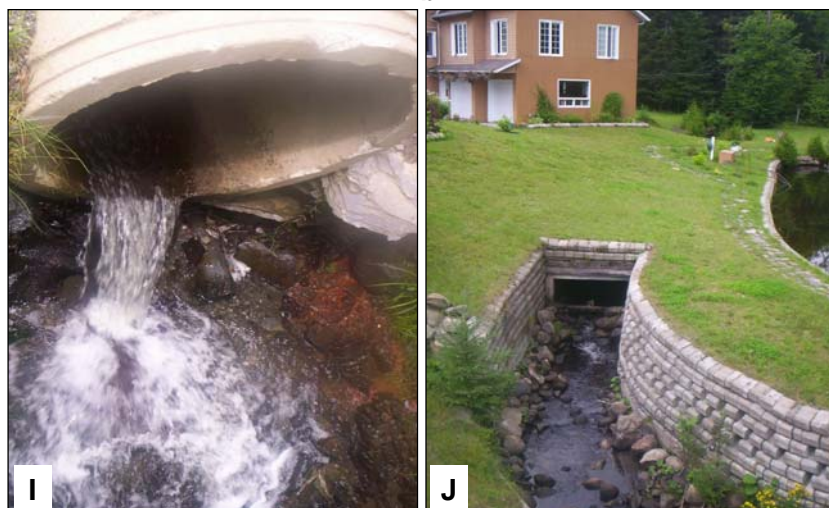
I : Ponceau surélevé (point 27) J : Artificialisation de la rive (point 28)
