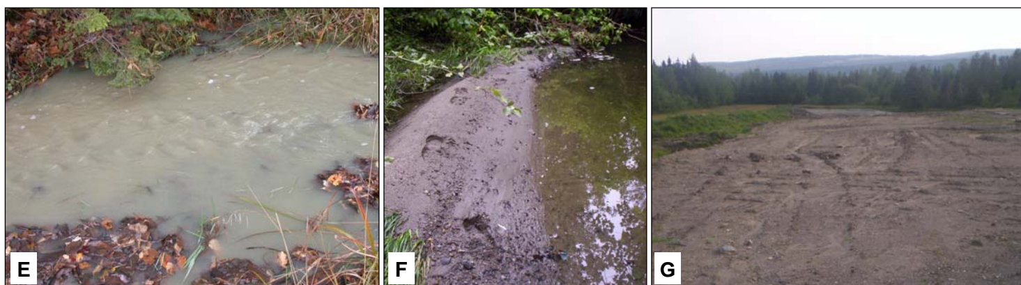
E : Eaux troubles par temps de pluie (point 9) F : Accumulation de sédiments (point 15) G : Sol à nu (point 19)
